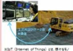
3次元設計データ等により、ICT建設機械を自動制御し、建設現場のIoT（※）を実施。
