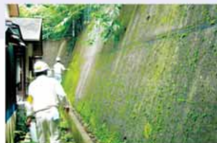
急傾斜地パトロール
