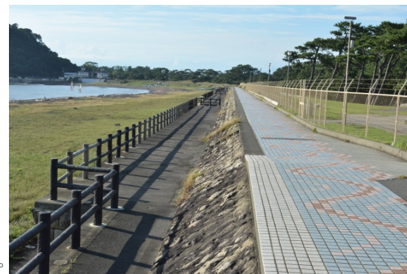
a) 堤防天端の舗装面の過度な装飾が、美しい海岸線の印象を弱めてしまっている。
