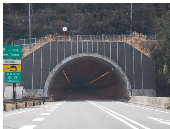
4-B 面壁を陰影のある化粧パネルで仕上げ、「見え方」を工夫した事例。（立野トンネル、伊豆市）
