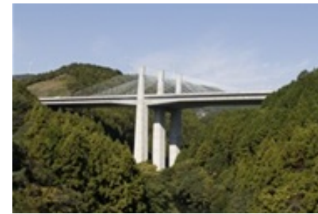
新東名都田橋は、斜長橋のタワーの高さを山の稜線を遮らないようにデザインし、山間部との調和が工夫されている。
