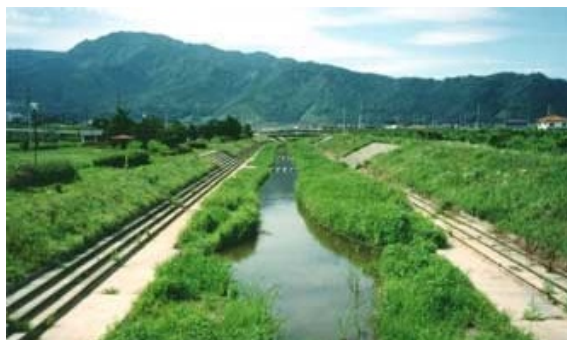
1-A 水際を覆土することにより、植生の再生を図っている。（濁川、長野県）
