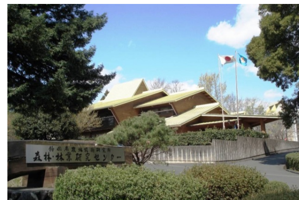
3-B 地域特性を踏まえ、木材を使用した事例（浜松市）
