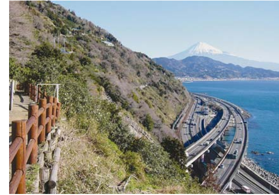
薩埵峠から眺めた東名高速道路の外部景観
