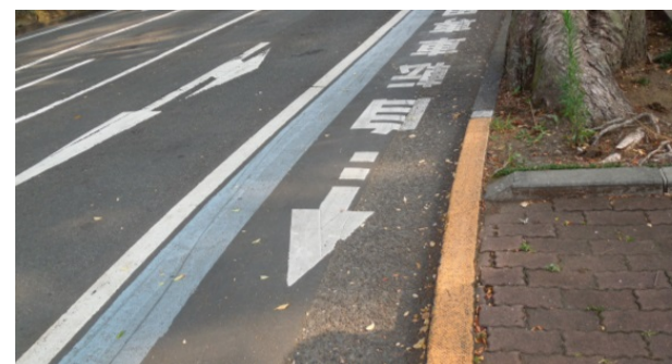
b) 帯状に塗装された青色のカラー舗装。自転車走行空間の区分は十分認識でき、a)に比べ安全と景観が両立。（県庁前、静岡市）
