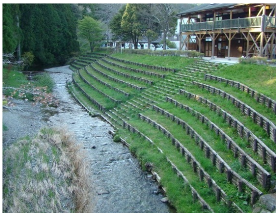
2-A 木柵を用いた緩やかな護岸中央には、水辺に降りる階段が護岸と同じ素材で整備されている。自然景観への調和と親水性を演出している。（気田川、浜松市）
