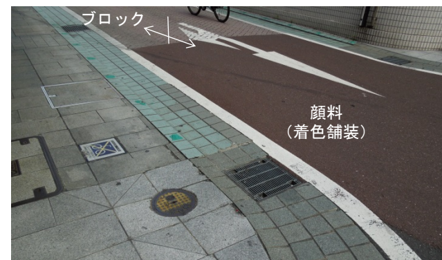
a) 同じ道路の手前と奥で、ブロック舗装と着色舗装が使われており、連続性がなく統一感のない印象を与える。
