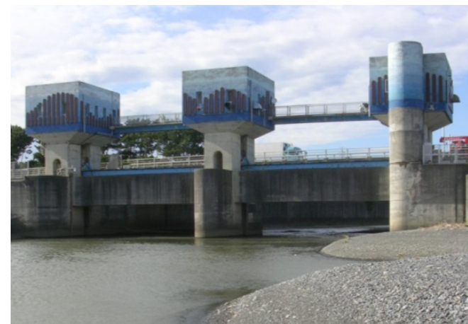
a) 唐突な印象を受ける管理棟と門柱ごとに異なる縦ラインの意匠により、構造物全体のまとまりが感じられない事例。
