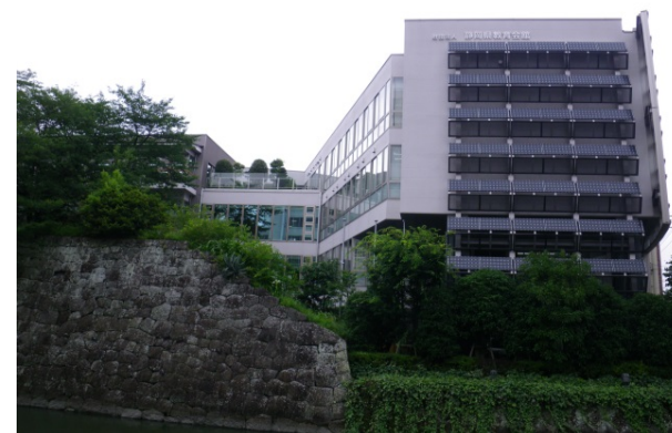
4-A 周辺景観となじませ圧迫感を低減する緑化（静岡市）
