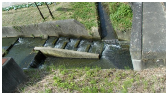
1-B 段差のある水路の片側は、魚の行き来ができるよう、階段状の魚道を整備している。
