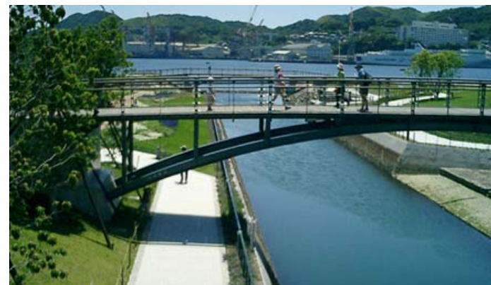
c) 桁下が歩道となっている橋梁は、下から見たときもスッキリと収まるように工夫されている。（長崎水辺の森公園、長崎県）
