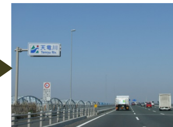
新天竜川橋付近（磐田市）
