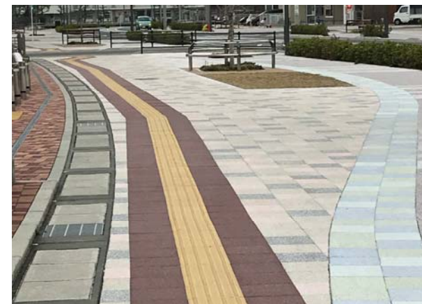
b)輝度比を確保するための縁取りにより色数が増え、煩雑な印象を与えている例
