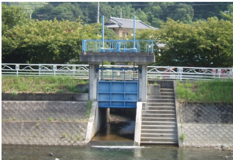
川＝「青」のイメージで塗装された樋門の様子。青い色は、自然界にない色のため、自然景観の中では特に目立った印象を与える。
