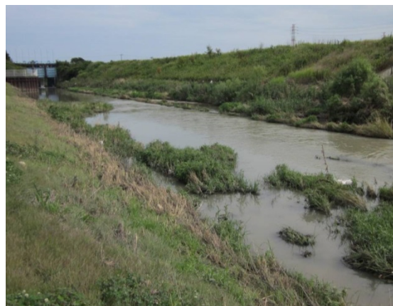
2-B 河床幅が広がる区間にワンドを整備した様子。ワンドにより「よどみ」が形成されて、多様な生物の生息空間が創出された。（蟹田川、磐田市）
