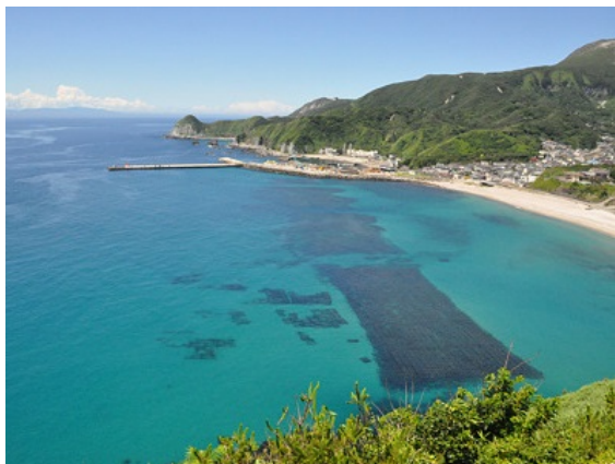
4-A 自然の海岸線に合わせて、潜堤が設けられている。（皆生海岸、鳥取県）
