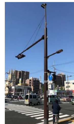
b) 機能が異なる道路附属物（道路照明、歩道照明、信号、標識）を一体化し、すっきりとした道路景観を形成している事例。(浜松市)
