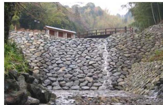
1-C 明治から大正に建設された砂防堰堤。石積み工法が周辺の自然景観と調和している。(木和田川砂防堰堤、藤枝市)
