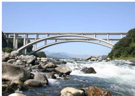
新東名富士川橋は、等間隔に配置された支柱がリズム感を出して、スッキリとしたデザインとなっている。
