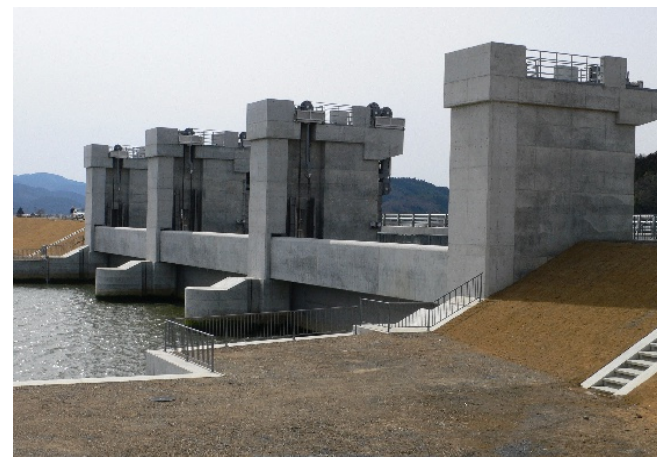
f) 上屋を設けず、通常外部に出る管理用階段、油圧発生装置類などを全て門柱内に収めることで門柱のフォルムを単純化した事例。(月浜第一水門、宮城県)
