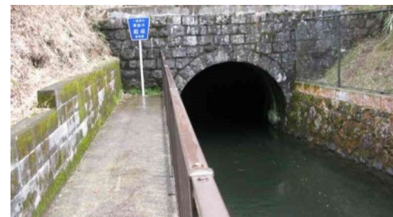
1-C 自然石を用いた護岸は、エイジング効果で歴史的な趣が演出されている。(深良用水、裾野市)
