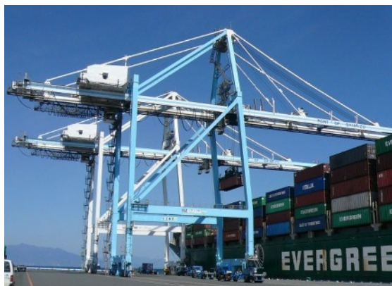
1-B 荷役作業の安全性や航空法による規制を考慮した上で、周辺景観と調和する色彩を採用している。（清水港、静岡市）
