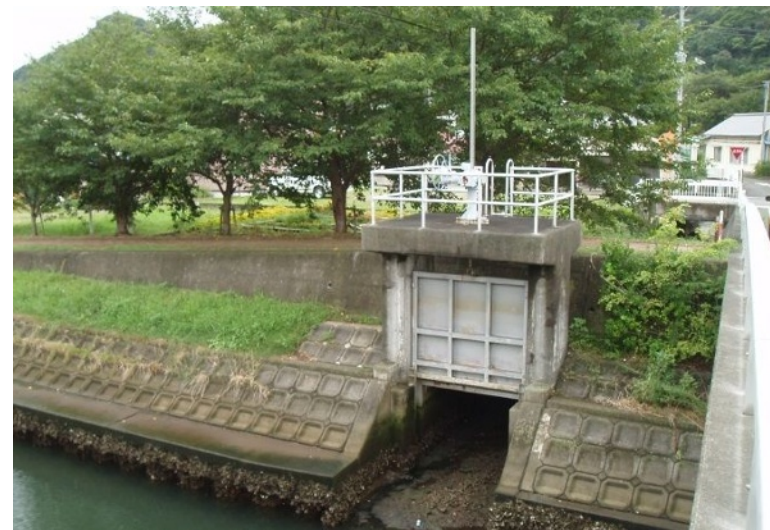
コンクリートと類似したグレーで塗装された樋門の様子。門扉は護岸や周辺とも違和感なく調和している。（浜条樋門、下田市）
