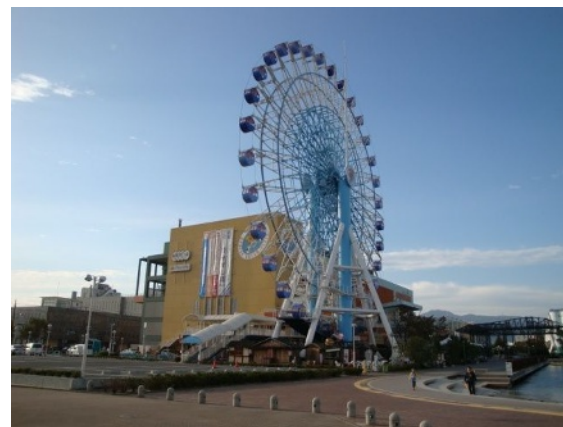
2-C 清水港は国際貿易港としての産業拠点だけでなく、多くの人々が交流する商業拠点が整備されている。（エスパルスドリームプラザ、静岡市）
