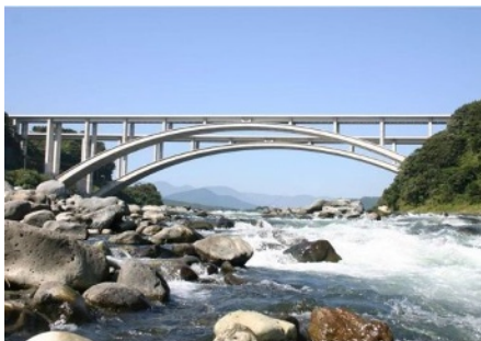
新東名富士川橋は、等間隔に配置された支柱がリズム感を出して、スッキリとしたデザインとなっている。
