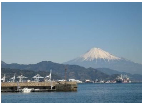
1-A 富士山への眺望を阻害しないように、港湾内の施設整備を行っている。（清水港、静岡市）
