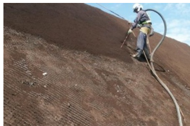
植生基材吹付
