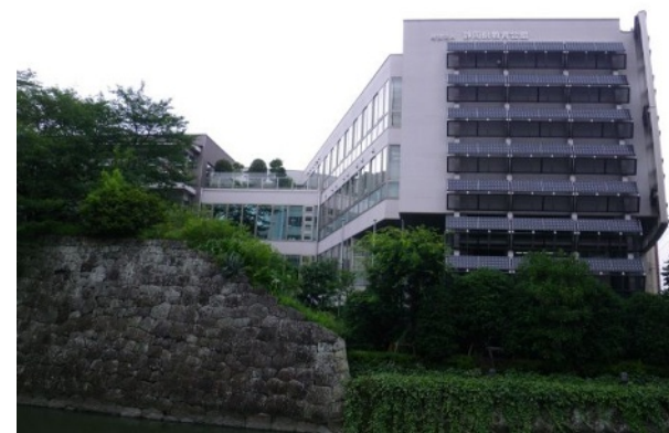
4-A 周辺景観となじませ圧迫感を低減する緑化（静岡市）
