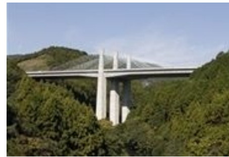
新東名都田橋は、斜長橋のタワーの高さを山の稜線を遮らないようにデザインし、山間部との調和が工夫されている。
