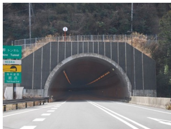
4-B 面壁を陰影のある化粧パネルで仕上げ、「見え方」を工夫した事例。（立野トンネル、伊豆市）
