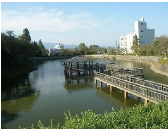
1-B 緑と水に囲まれ、緑と水の回廊の眺望ポイントとして展望デッキが整備されている。（船越堤公園、静岡市）
