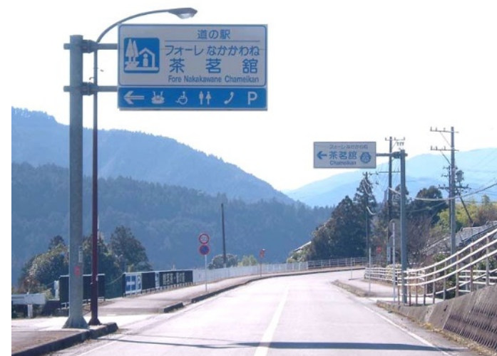
a) 同様の情報が、道路案内標識と著名地点誘導サインで重複しており、集約化することが望ましい。(現在は集約化されている)
