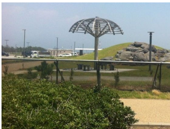
2-B 田子の浦港の泊地・航路浚渫で発生した残土を活用し、潤いと憩いの場となる緑地公園が整備された。（ふじのくに田子の浦みなと公園、富士市）
