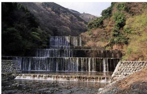
1-A 単独で大規模な施設の代わりに小規模な施設を複数基設置することで周辺環境に調和している。(水無川、神奈川県)
