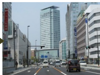
静岡市葵区柴町地内
