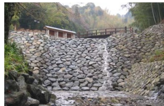
1-C 明治から大正に建設された砂防堰堤。石積み工法が周辺の自然景観と調和している。(木和田川砂防堰堤、藤枝市)
