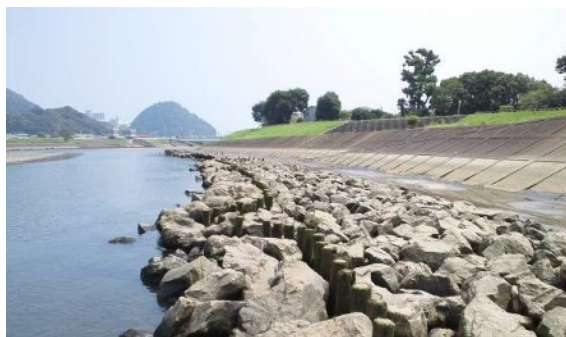
1-B 水際には寄せ石を行い、水際の安定と魚類の成育場所を確保している。
