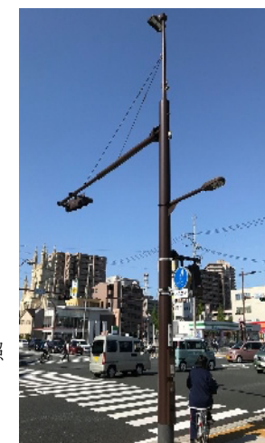
b) 機能が異なる道路附属物（道路照明、歩道照明、信号、標識）を一体化し、すっきりとした道路景観を形成している事例。(浜松市)
