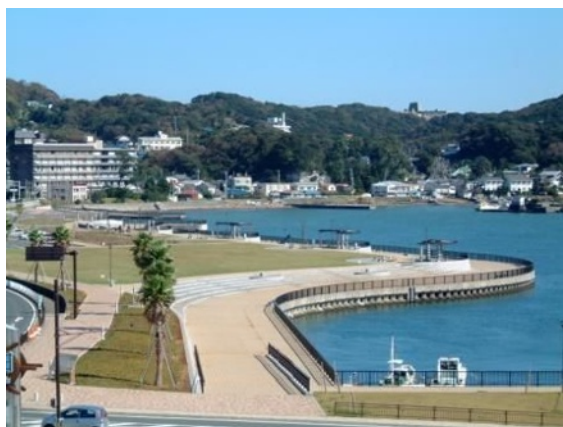
2-A 下田港や海岸への眺望を楽しむ散策路が整備されている海浜公園。（まどが浜海遊公園、下田市）
