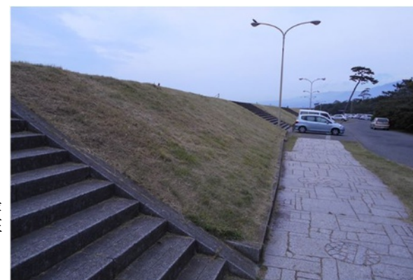
b) 階段による分節と法面緑化により、長大な印象や圧迫感が軽減されている。 (千本松原海岸、沼津市)
