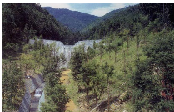
1-B 堤体の前面に砂防堰堤の高さと同程度の植栽が施され、施設の圧迫感を緩和している。(西の谷川えん堤、京都府)
