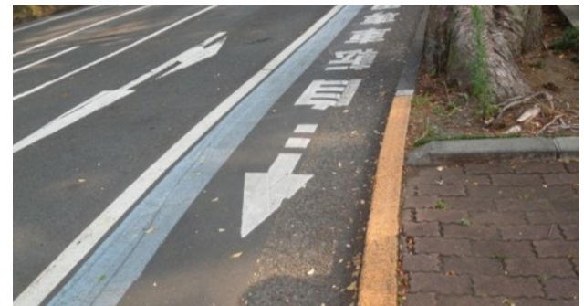
b)帯状に塗装された青色のカラー舗装。自転車走行空間の区分は十分認識でき、a)に比べ安全と景観が両立。(県庁前、静岡市)
