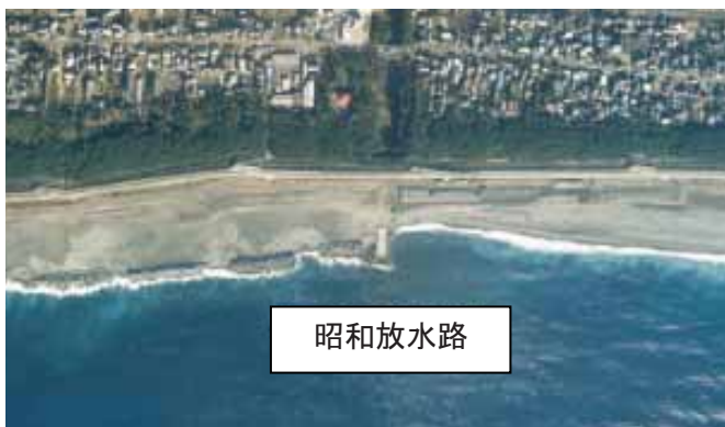
図 2.9 昭和放水路下手側の侵食状況
