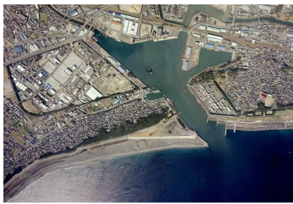
写真-1.5 現在の河口付近の様子
