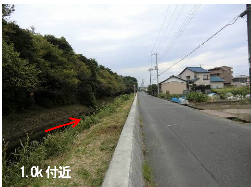
写真-2.1 パラペット築堤状況
