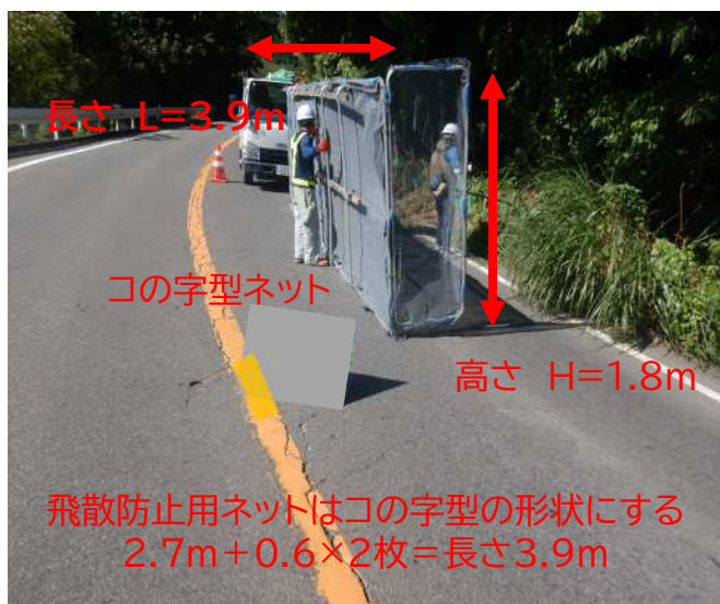
コの字型飛散防止ネット(ピンク色部分を追加)
