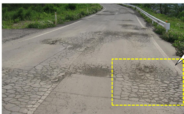
付写真-1.1 亀甲状ひび割れの例
