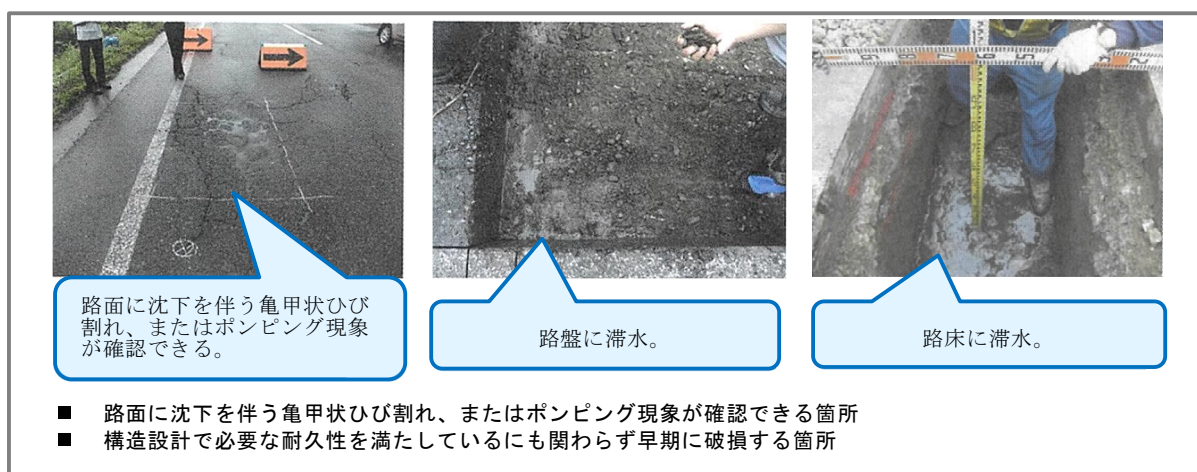
図解-3.4 開削が必要な箇所の例
