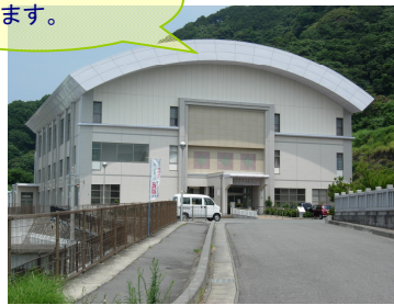
⑤ 静浦地区コミュニティ防災センター（沼津市獅子浜） （小学校体育館、市民窓口と合築）
