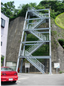
④ 避難階段（沼津市多比） （急傾斜地崩壊対策法面に階段を設置）
