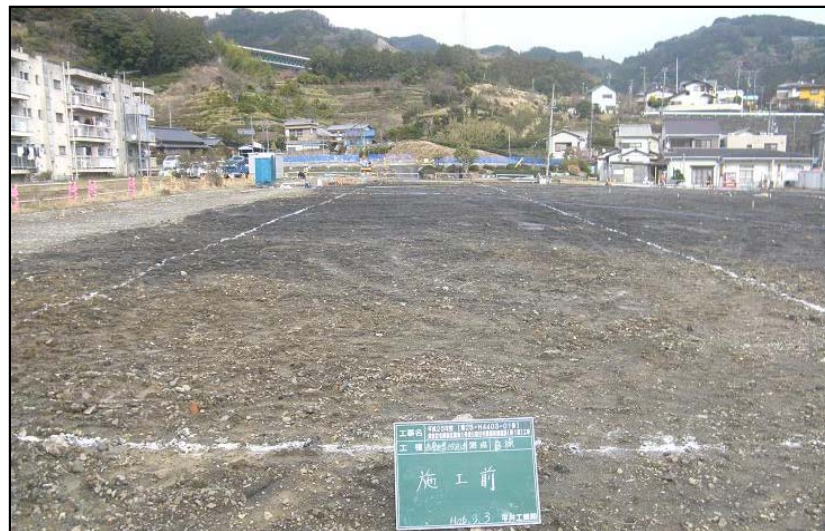
着手前(解体後)
