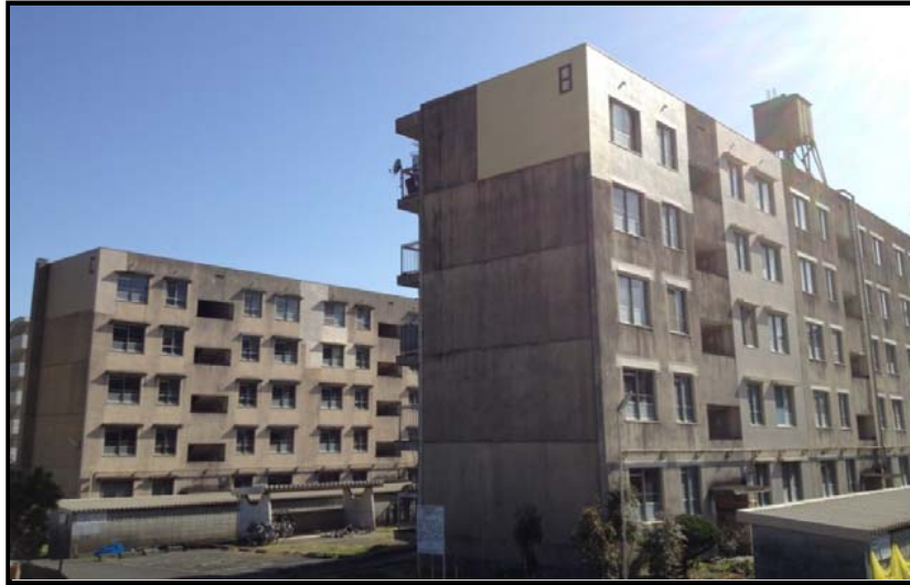
着手前(解体前)
