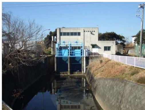
図-3.5.5 塚本排水機場
