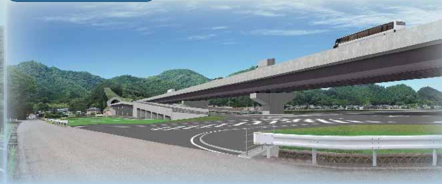
④ 大平地区(高架橋区間)
