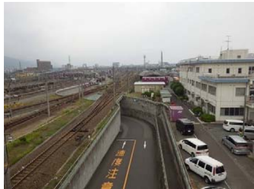
○東海道本線(下り)を交差する地下通路
