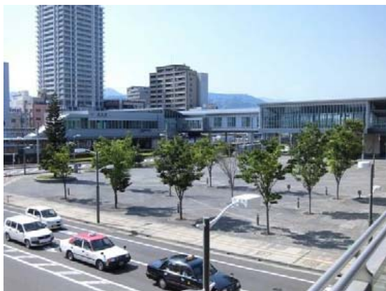
○東西自由通路全景
