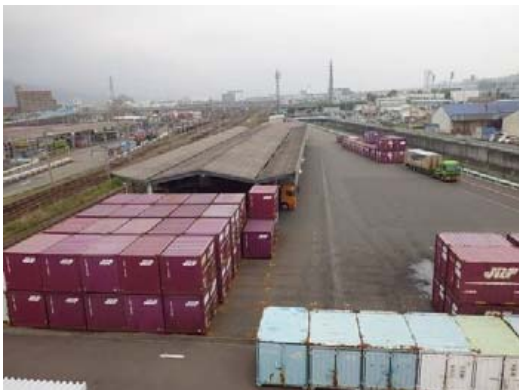
○コンテナ荷捌上屋及びコンテナ置場
