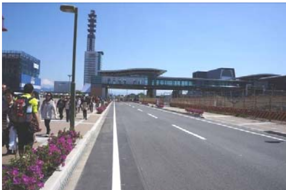
○南北自由通路全景
