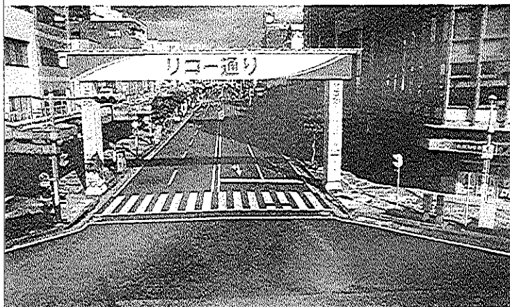
あまねガードから国道1号線方向 4車線
