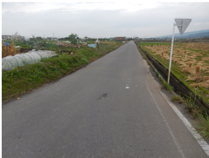
雁作川(市道116号)西方向 沼津市鳥谷
