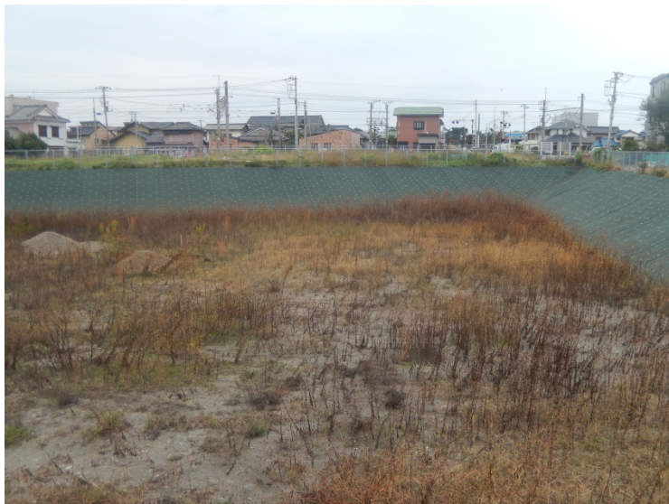
沼川新放水路1号暫定調整池 沼津市大塚
