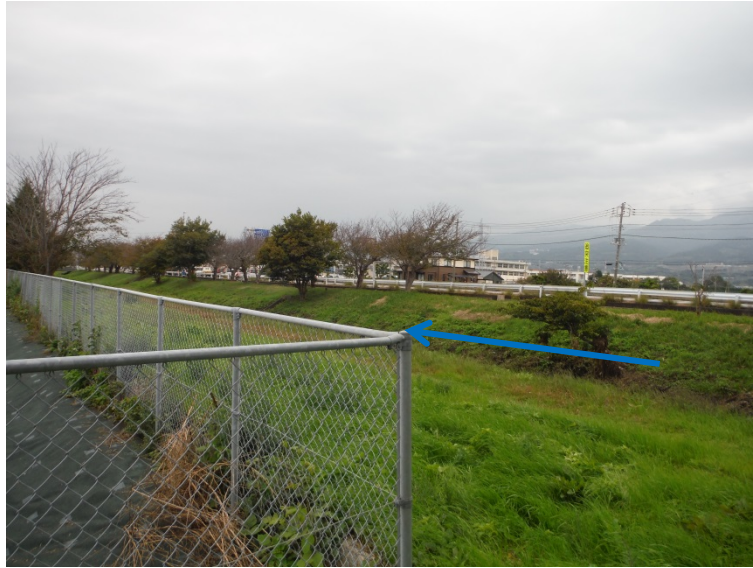
沼川新放水路5号暫定調整池から沼川方向 沼津市大塚
