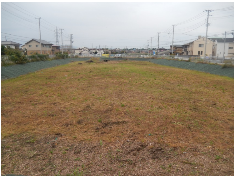
沼川新放水路4号暫定調整池 沼津市大塚
