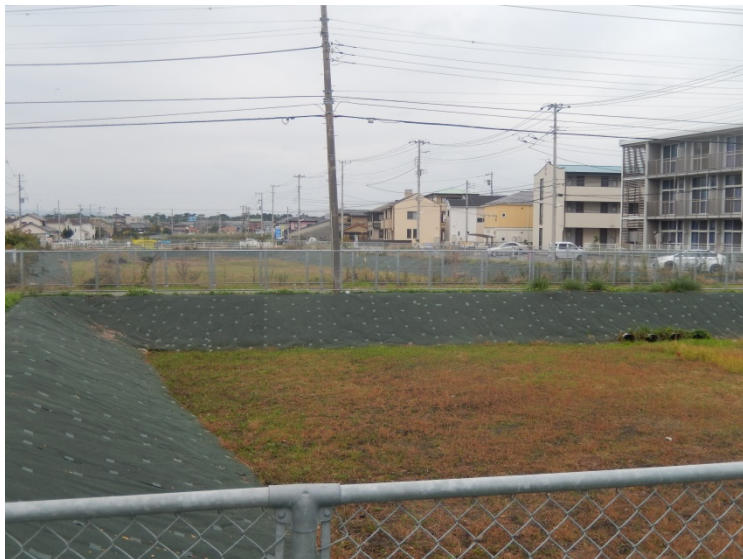
沼川新放水路5号暫定調整池 沼津市大塚
