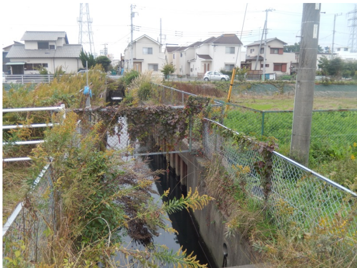
沼川新放水路2号暫定調整池・東部前川 沼津市大塚
