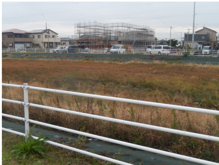
沼川新放水路3号暫定調整池 沼津市大塚
