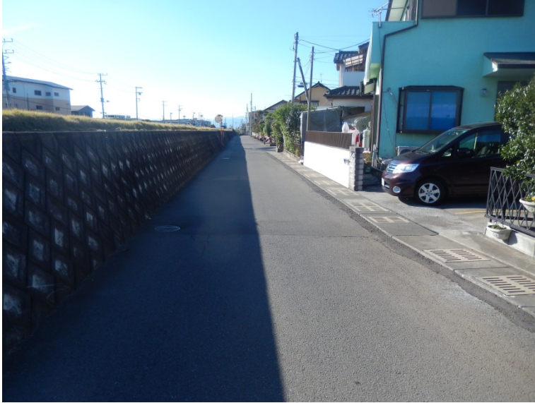
中沖橋下流部右岸側付近 沼津市青野
