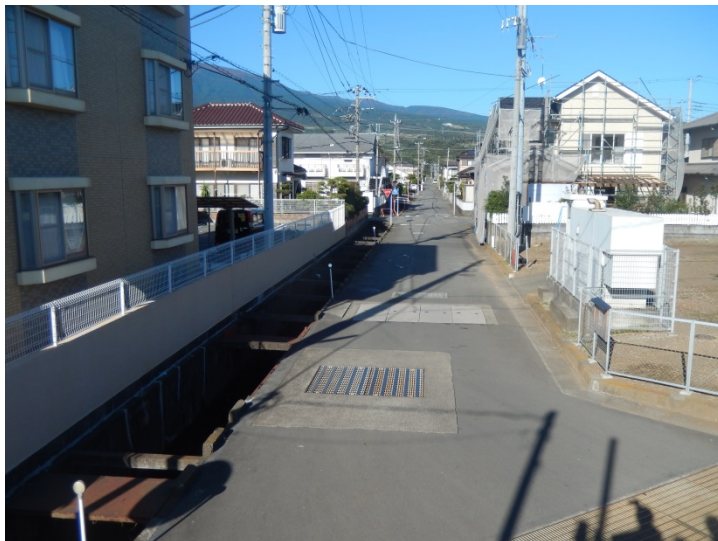
中沖橋～三合橋右岸側付近 沼津市青野
