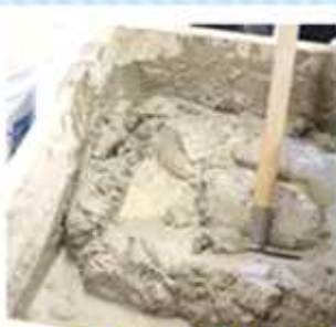
ざいりょう ま かた ちようせい 材料を混ぜて硬さを調整
