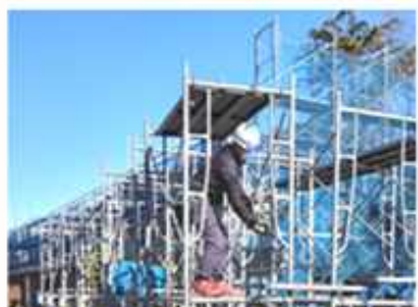
けんせつさくぎょうをささぐ、あしばのくみだて 建設作業を支える、足場の組立て
