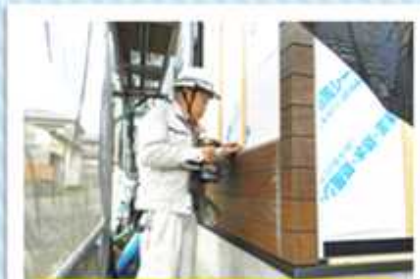
住宅の外壁も板金の仕事
