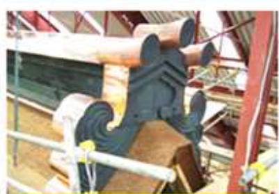
屋根の先端の瓦を覆う銅板
