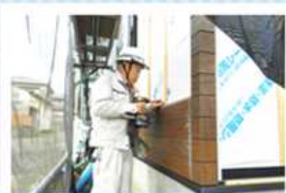
Ang panlabas na pader ng bahay ay trabaho rin ng tekniko sa sheet metal.
