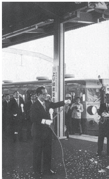
14 下り高架から1年半、静岡駅上り線の高架が開通した。〔昭和53年度版〕
