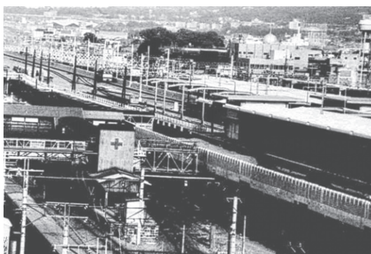
13 静岡駅高架下り線開通〔昭和52年度版〕
