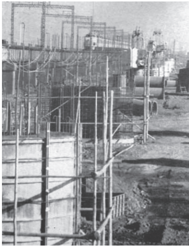
5 新幹線の基礎工事(安倍川) 〔昭和36年版〕
