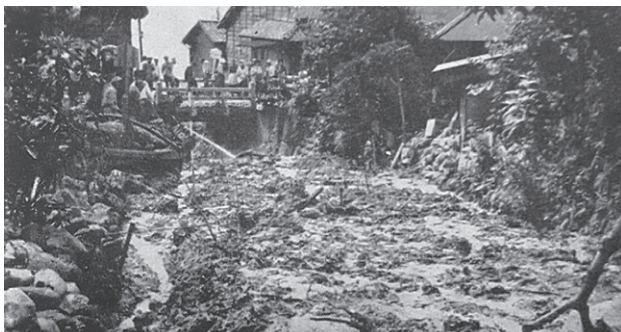
26 昭和 36 年の由比町の地すべりでは土砂が川を埋め、民家近くまで土砂が押し寄せた。〔昭和 36 年版〕
