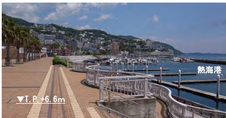
図 1-17 熱海港海岸防潮堤の整備状況
