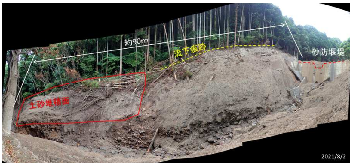
写真④ 砂防堰堤の下流右岸の流下痕跡と土砂堆積状況
