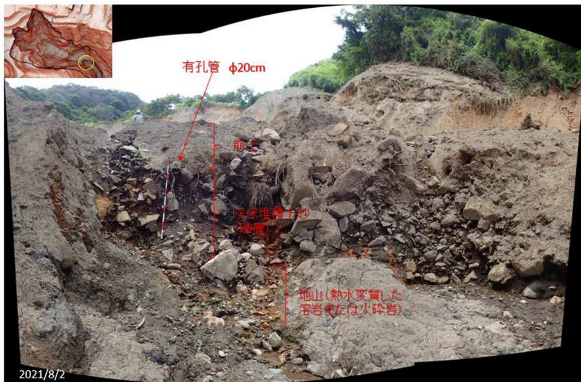
写真⑩ 崩落地下端付近に見られる有孔管
