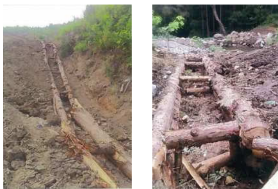
2011. 8 法面補修工事 (熱海市写真 8)
