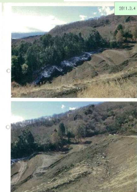
写真6 2011(平成23)年3月4日 県及び市で合同調査
