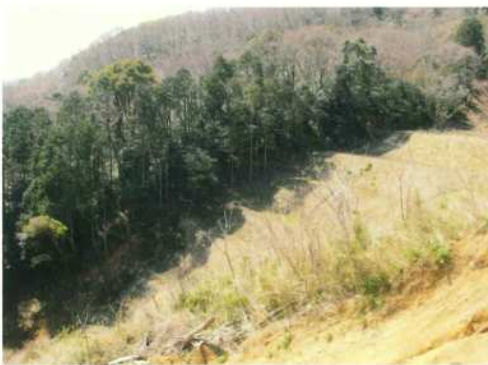
残土による盛り土法面
