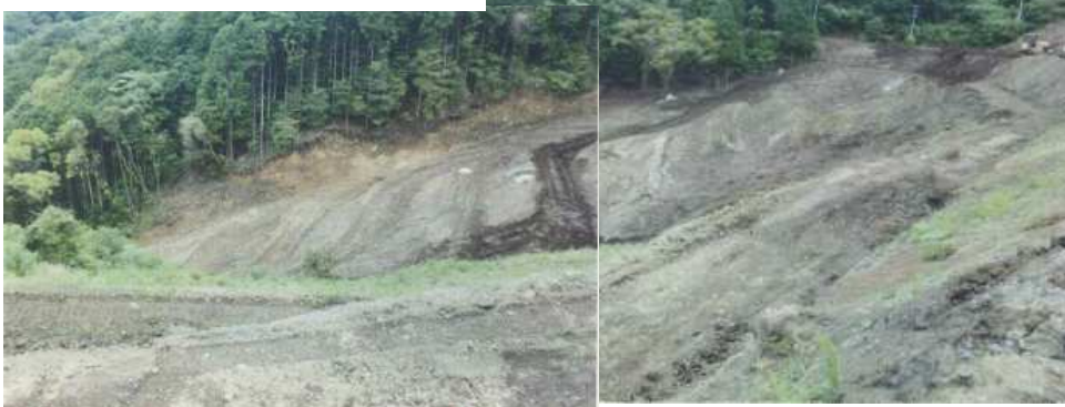
E 社の盛り土完了(植生未施工)
