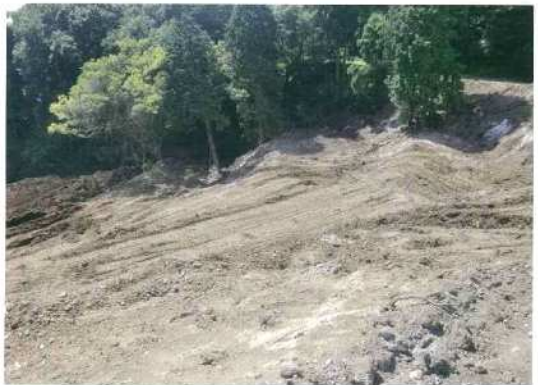
写真3 2010(平成22)年8月30日 崩れた土砂の成形作業を確認
