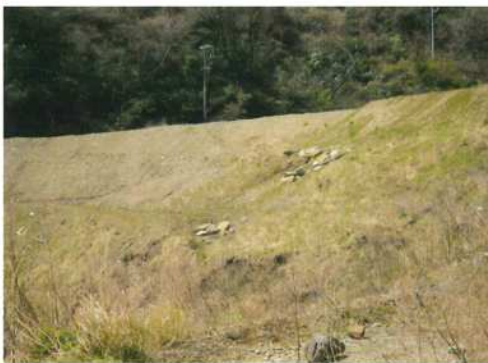
法面の緑化状況
