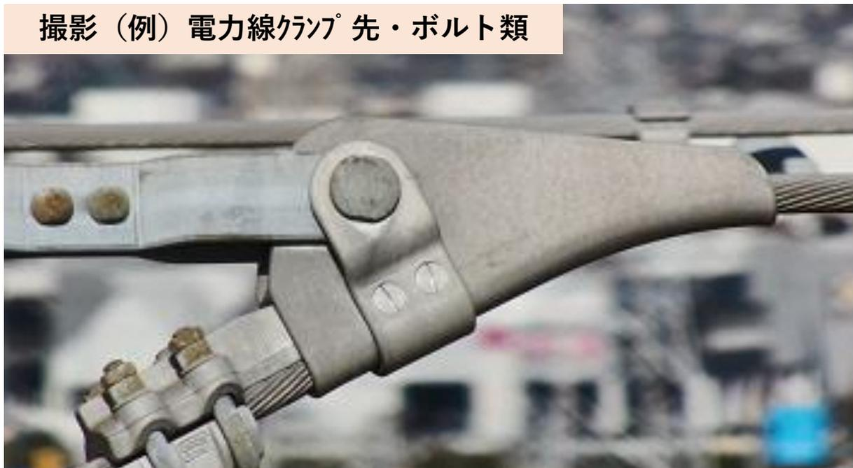
撮影（例）電力線の振動防止装置
