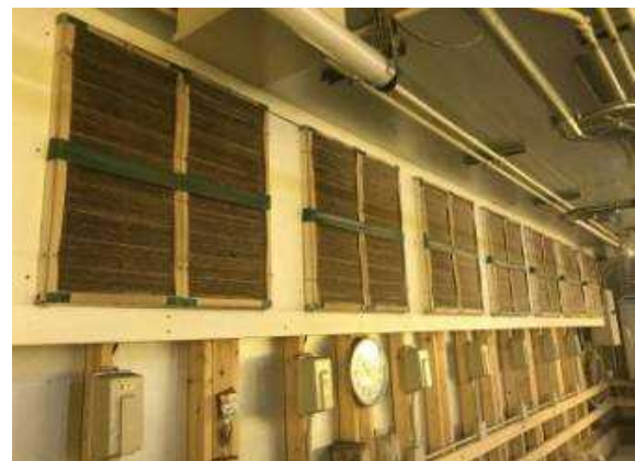
写真 畜舎内フィルター設置の様子
