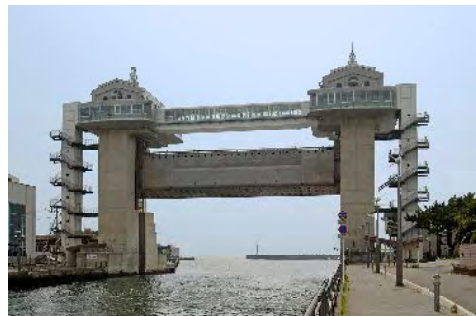
津波対策水門びゅうお
