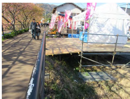
仮設鋼管転落防止柵
