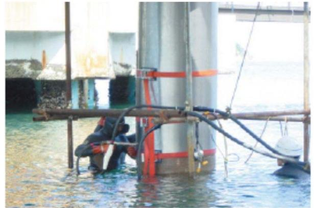
TP工法(鋼管杭)取付状況
