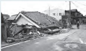
▲平成28年熊本地震で倒壊した木造住宅
