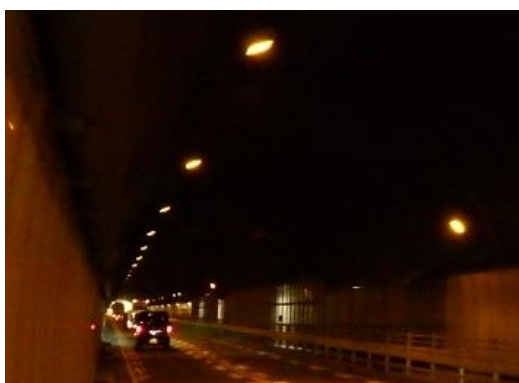
トンネル照明灯の LED 化
