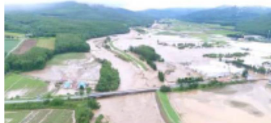
[空知川における浸水被害(北海道富良野市)]
