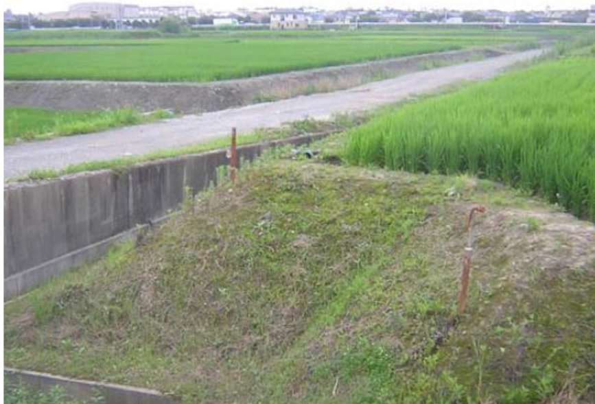
図 2-6 農地の盛土の様子
