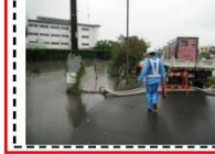
1-7 緊急時のポンプ排水 可搬式ポンプの設置
