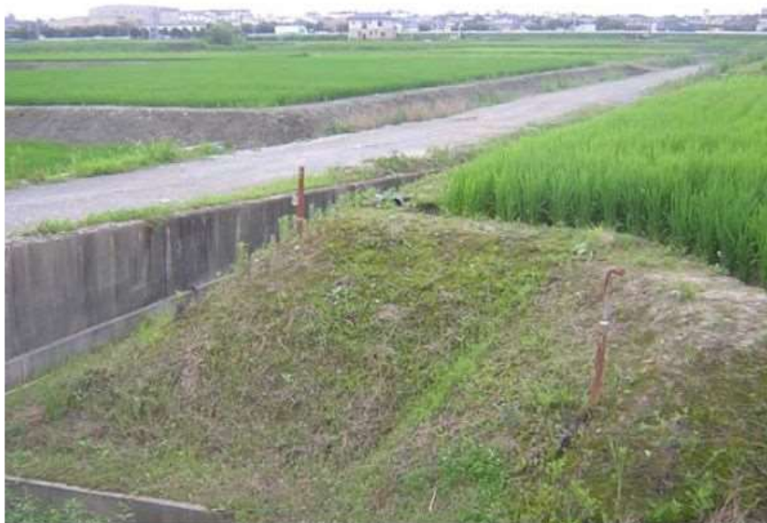
図 2-6 農地の盛土の様子
