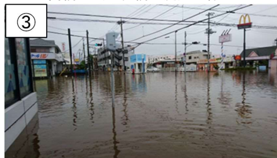
県道原停車場線付近の様子
