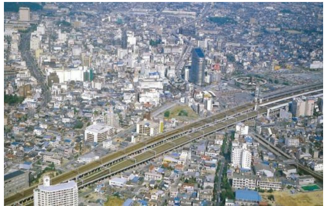
図1-1-7 浜松駅付近連続立体交差事業
