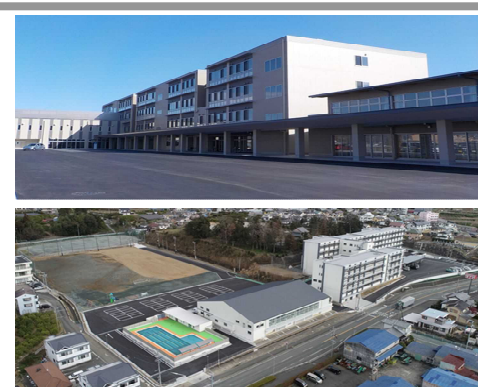
<(上)伊豆の国(下)浜松みをつくし>
