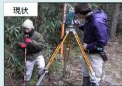
現地に測量機器を設置し、 土地の境界点の座標値を測量
