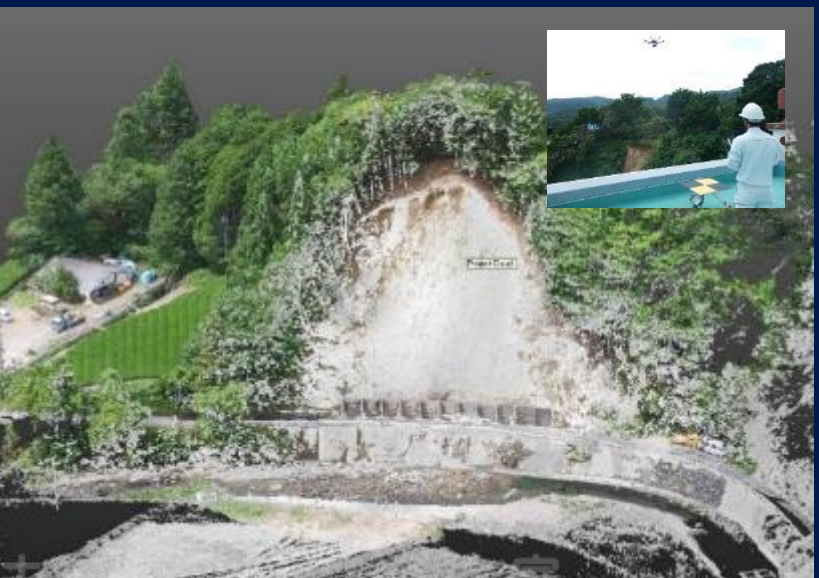
被災後に3次元点群データ計測
