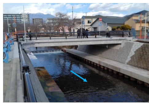
柳田橋上部工完成 (R7.12.26供用)
