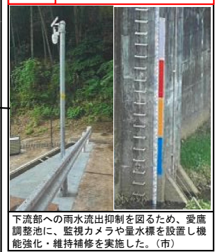
①-6 調整池の活用や機能向上 下流部への雨水流出抑制を図るため、愛産調整池に、監視カメラや量水樞を設置し機能強化・維持補修を実施した。(市)
