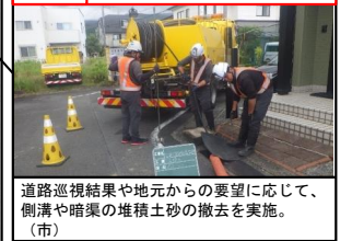
①-13 道路の適切な維持管理 道路巡視結果や地元からの要望に応じて、側溝や暗渠の堆積土砂の撤去を実施。(市)
