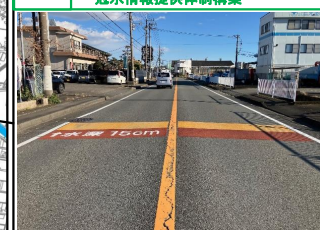
弥生線に冠水状況を分かり易くするため、水深路面表示を設置。（市）
