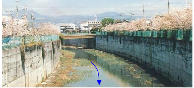
大谷川放水路（中流部）
