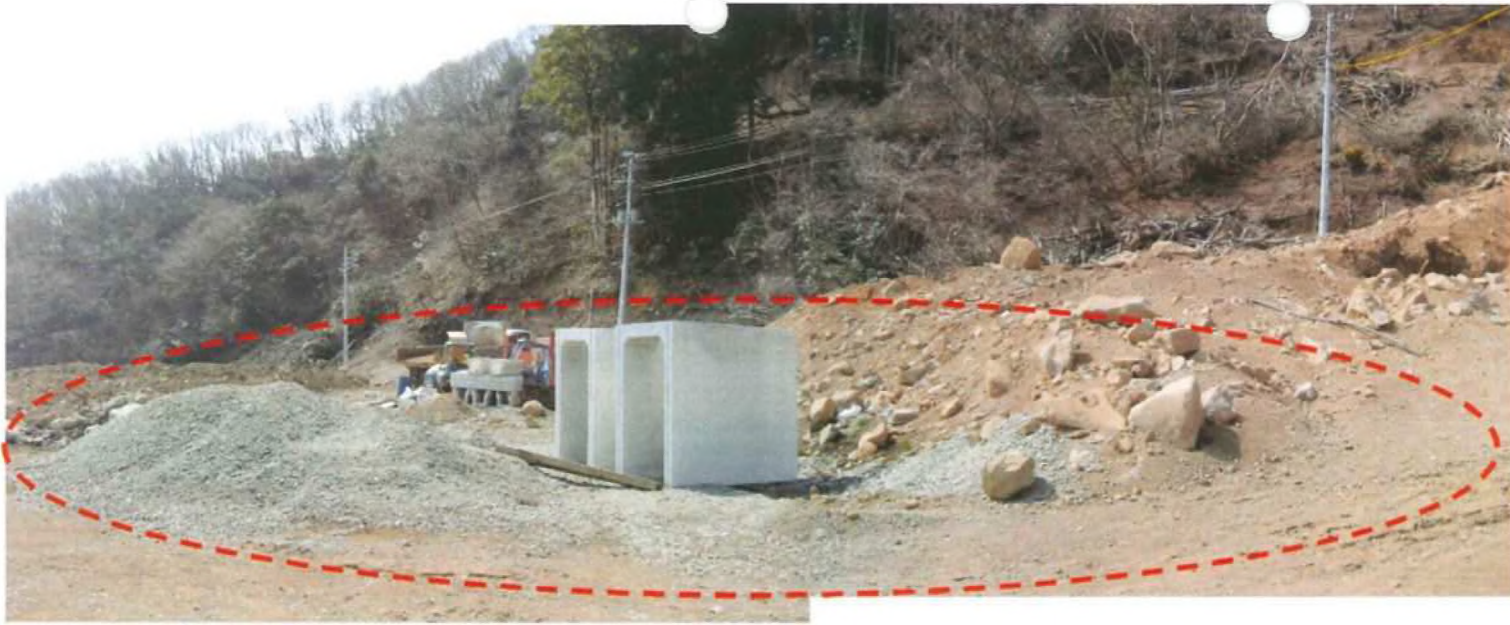
⑤最上流 宅地造成部分 No.3 部分 (求積もれ)
