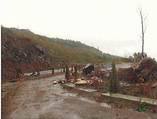
03放置状況(伊豆山宅地分譲) 2009/11/11 10:25:05
