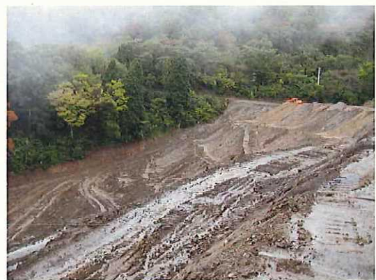
06法面状況(伊豆山土採取) 2009/11/11 10:34:44
