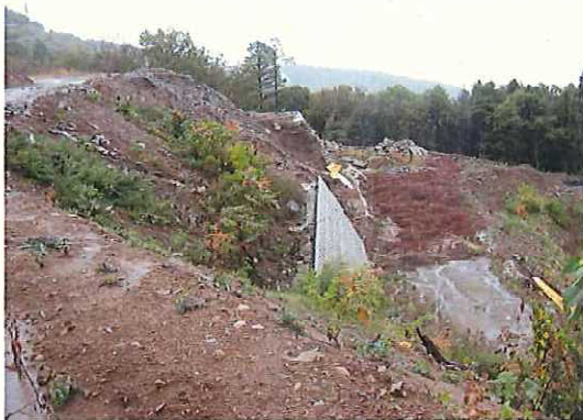
01放置状況(伊豆山宅地分譲) 2009/11/11 10:23:05
