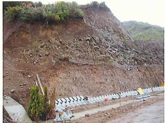
02放置状況(伊豆山宅地分譲) 2009/11/11 10:24:54
