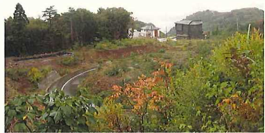
04取付道路遠景(伊豆山宅地分譲) 2009/11/11 10:23:18
