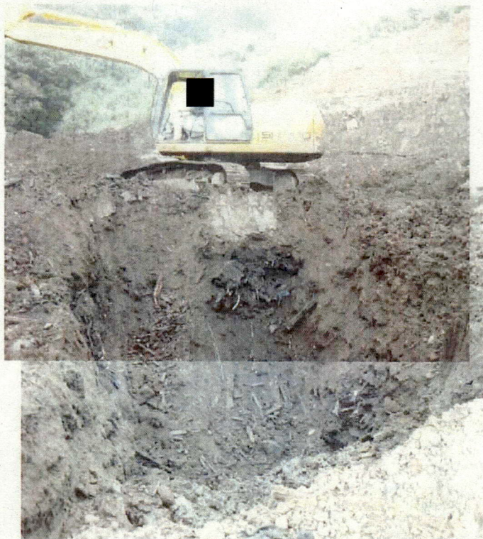
写真⑧重機の手前が掘った穴
