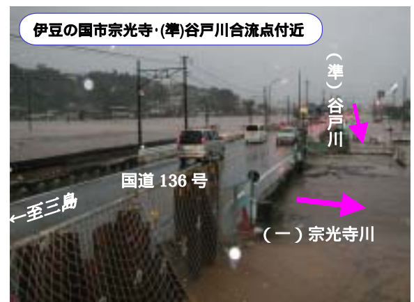
図 34 宗光寺川浸水状況（平成 16 年 10 月）
