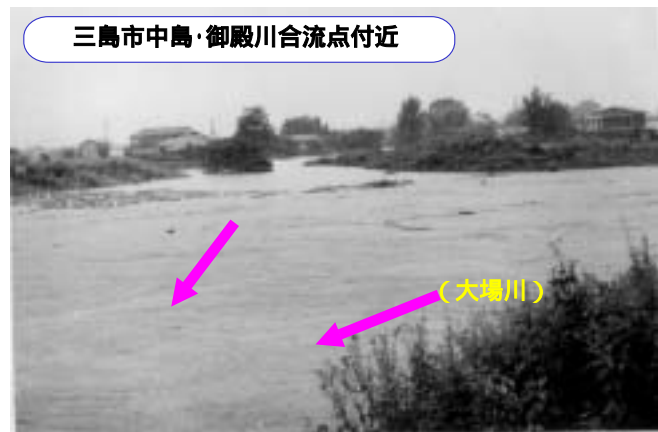
図 28 御殿川出水状況（昭和 36 年 6 月）
