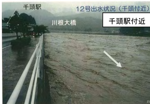
写真 2-7 平成 23 年 9 月台風 12 号洪水の状況
