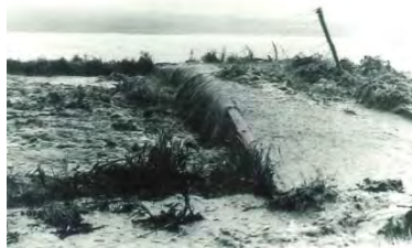
写真 2-3 昭和 57 年 9 月洪水の浸水被害状況
