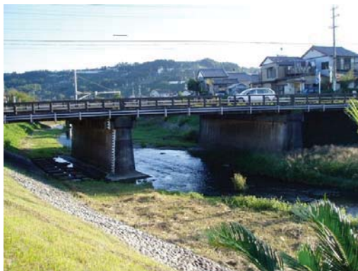
大代川橋水位観測所
