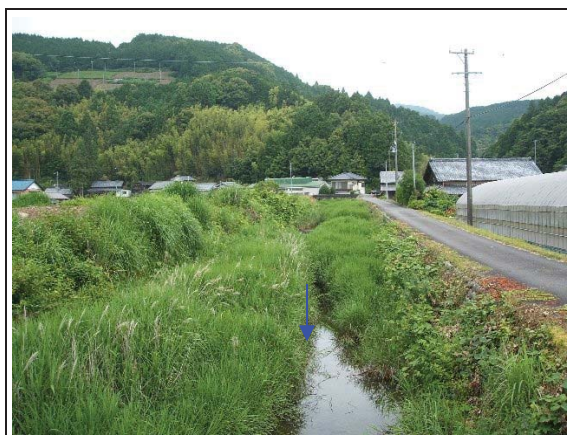
▲下流部の護岸整備
