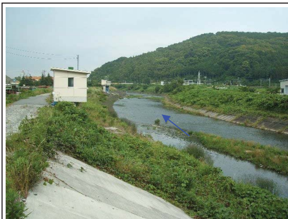
▲大井川の堤防高さに合わせた築堤工事_高橋より
