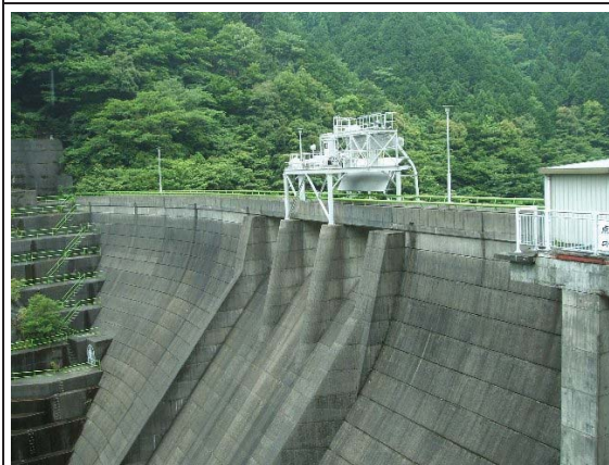
▲調節容量 61.5 万 m 3 の大代川農地防災ダム
