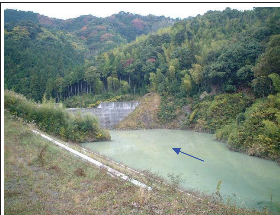
▲約11万m 3 の容量を持つ田代調整池(島田市管理)
