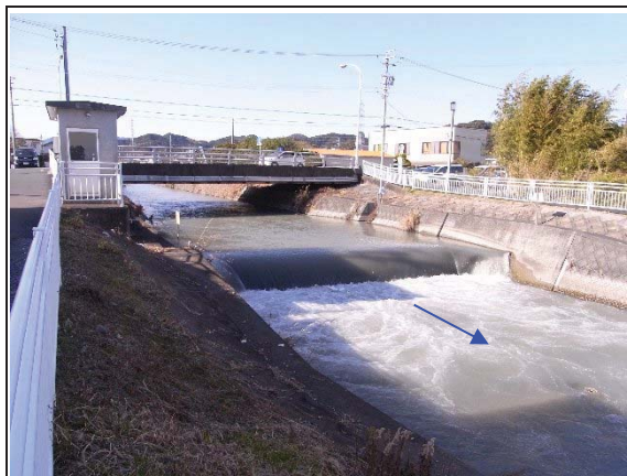
▲下流部は大井川用水の通水路として利用_中河橋下流より
