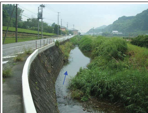
▲パラベットによる部分的な対策箇所_代の田橋下流より
