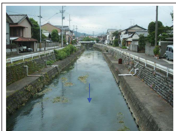
▲ 複断面河道で整備_清見橋より
