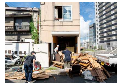
▲活動拠点整備に向けたリノベーション作業。 多くの人手と労力によって支えられている。
