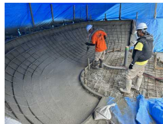
▲スケートパーク施工状況
